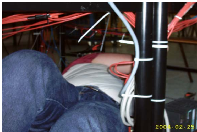
Mühselige Kabelverlegung unter der Arbeitsplattform
